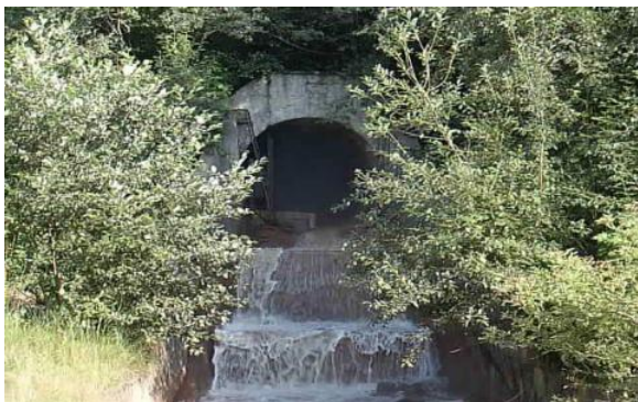
Fig. 6 Galerie de evacuare ape limpezite
