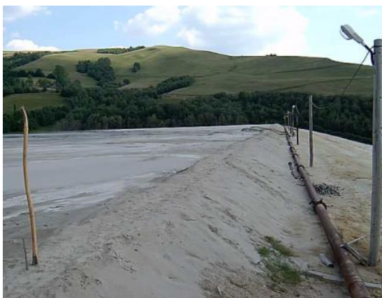
Fig. 3 Conducta de distribuție
